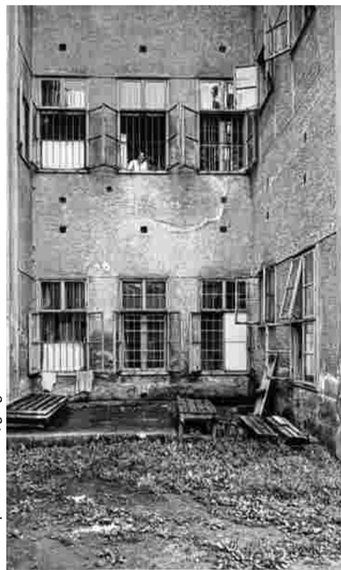
Desaströse Zustände nach 1945.
