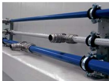
zierte Hilfsmittel wie etwa Bördelmaschinen überflüssig sind. Der Montageprozess besteht bei allen Dimensionen aus nur zwei Arbeitsschritten: stecken + sichern = fertig.
